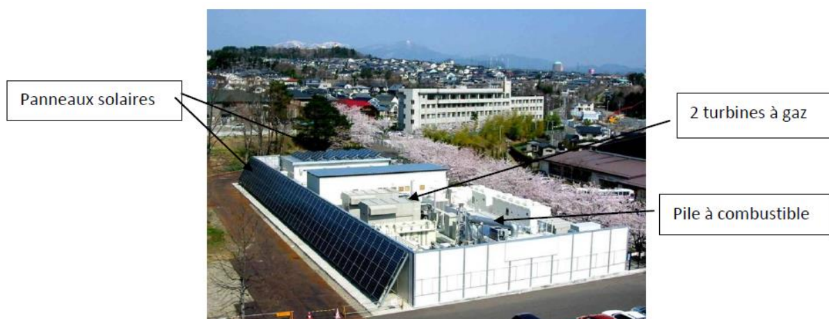
NTT Facilities, Production décentralisée d'énergie à Sendai (Source : Wikipedia)
