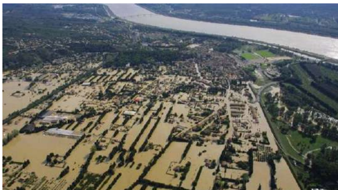
Photo de la crue du Rhône en septembre 2002.
