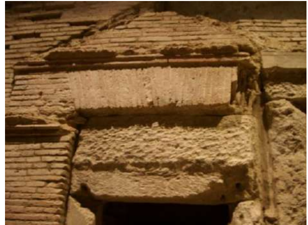
Photo du Linteau de laerarium
